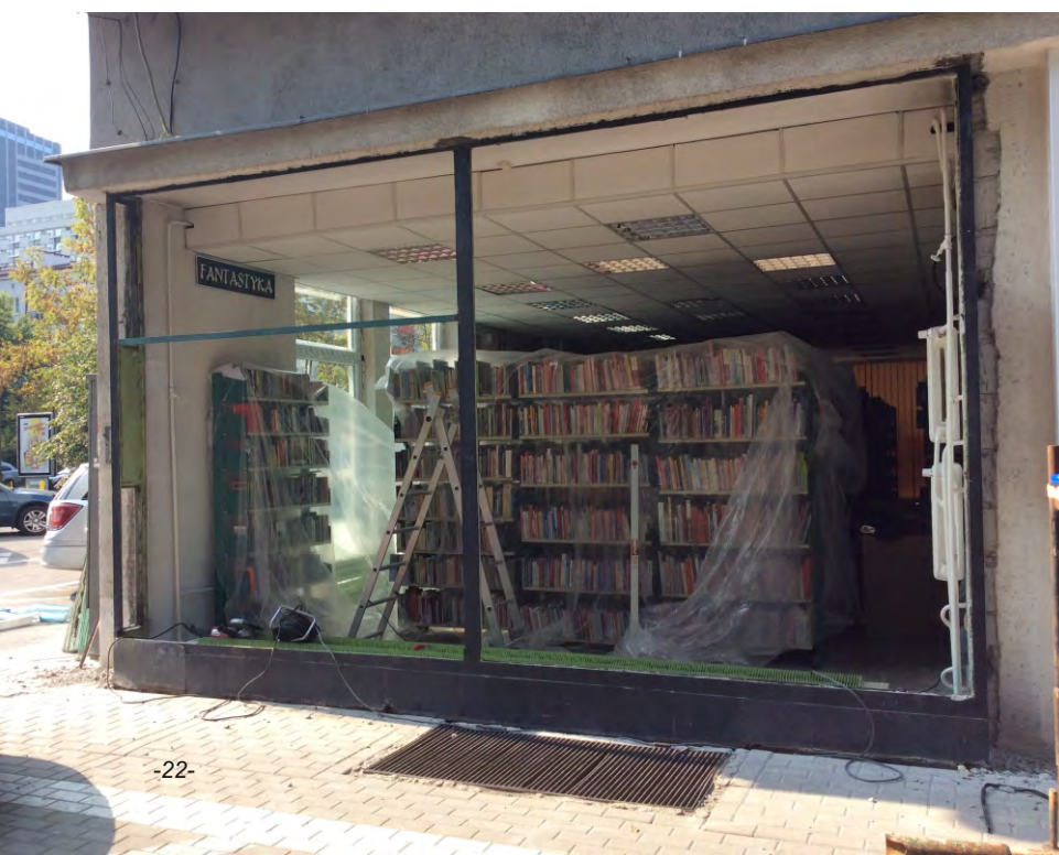
Zdjęcie 2 Prace remontowo- budowlane
