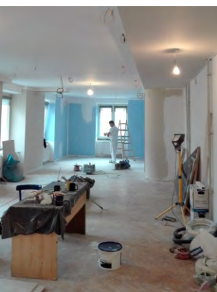
Zdjęcie 3 W trakcie remontu
