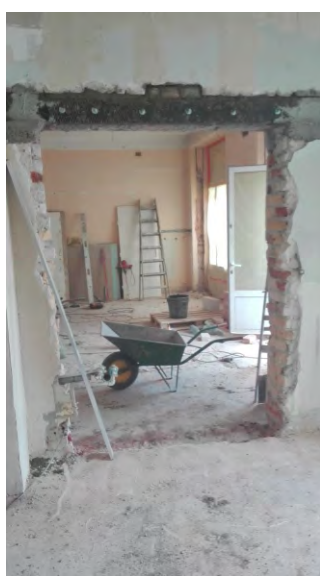
Zdjęcie 3 W trakcie remontu
